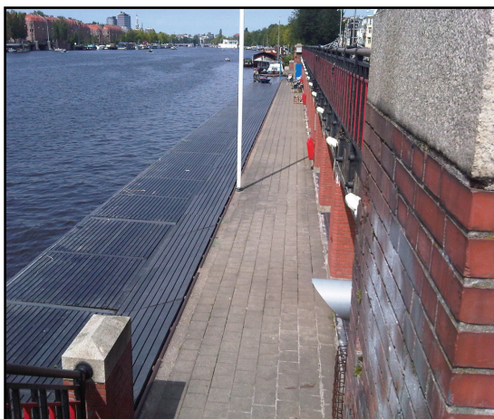
roeicentrum in de Schollenbrug
